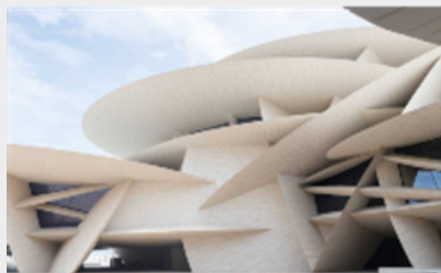
«Роза пустыни» от Жана Нувеля в Дохе — новая библиотека, которая становится уникальной достопримечательностью и сложным пространственным объектом.
